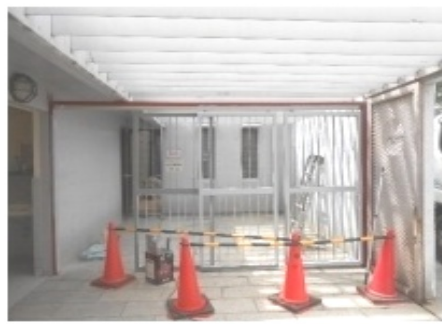
【トイレ横に外部倉庫設置】
